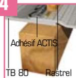
Recubrir los solapes con la cinta adhesiva Actis ISODHESIF e idealmente sellar con un rastrel para asegurar la estanqueidad.
